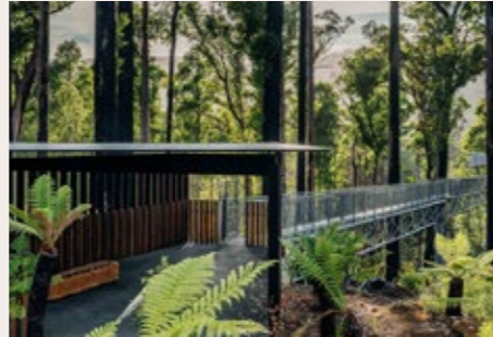
TAHUNE AIRWALK PAVILION - TANNER ARCHITECTS
