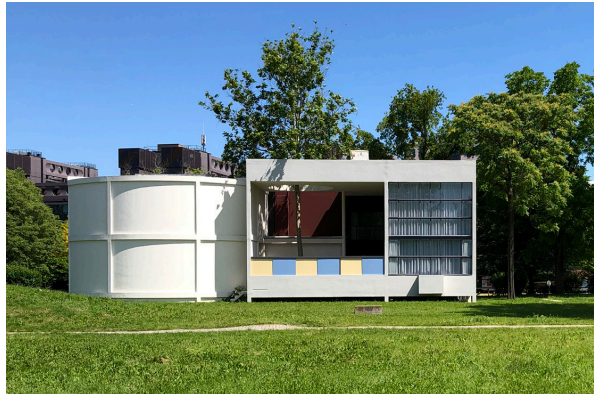
Pavillon de l'Esprit Nouveau, Le Corbusier
